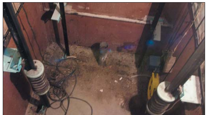
«Стакан» под противовес. Трубу монтажники сами приобрели и приварили
