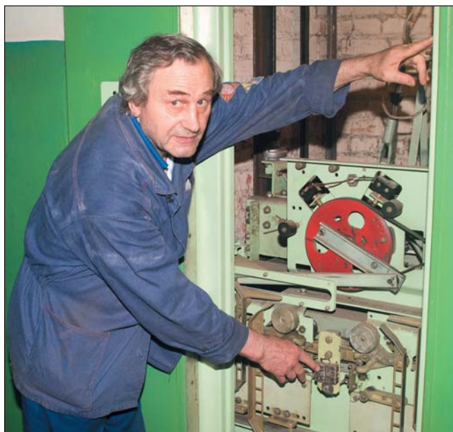
Электромеханик Виктор Павлович Шишкин обслуживанием лифтов занимается с 1972 года: «Вот эти контакты на дверях кабины, которые может разомкнуть любой недисциплинированный пассажир. В результате лифт останавливается, и чтоб он заработал – я должен выходить на объект и запускать систему»
